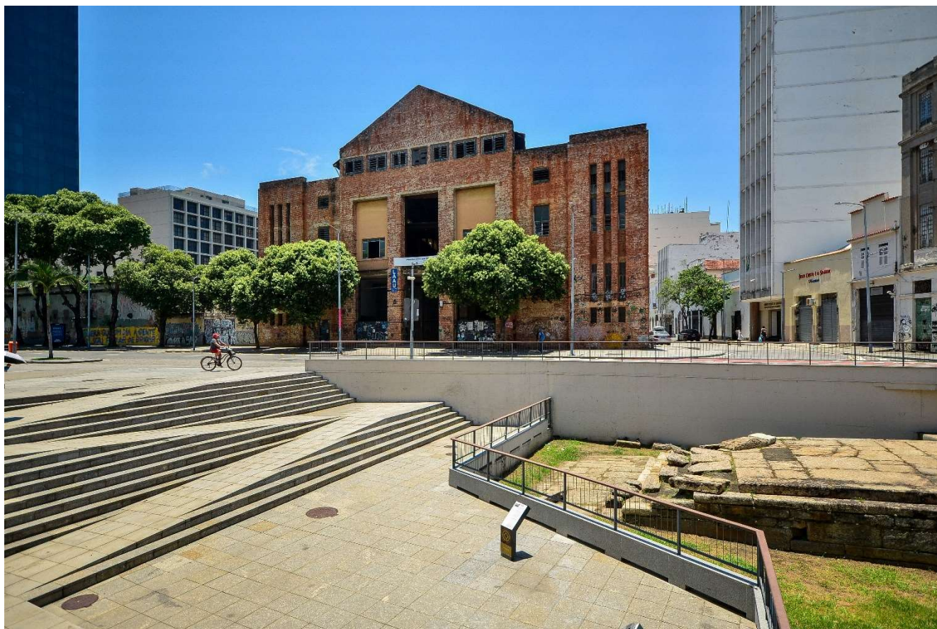
Prédio das Docas André Rebouças (antigo Prédio das Docas de D. Pedro II). Fonte: Consórcio Valongo Patrimônio Vivo. Fotografia: Arthur Cordeiro (2025)
